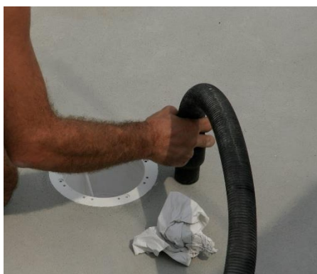
Figura VI – Pulizia del fondo mediante aspiratore
