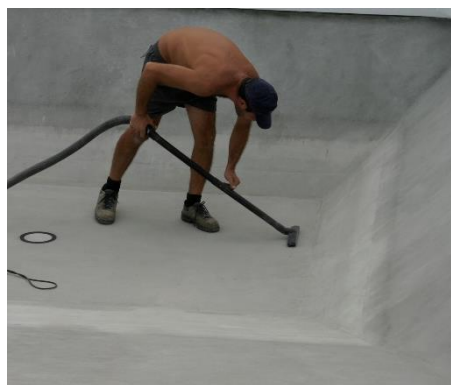
Figura VII – Pulizia del fondo mediante aspiratore
