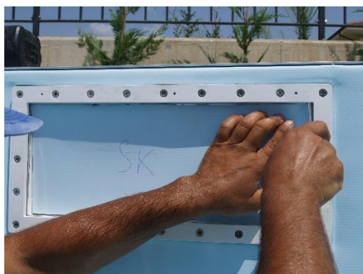
Figura XI - Assemblaggio delle flange
