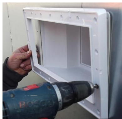
Figura III - Assemblaggio pezzi a murare
