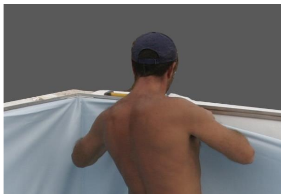
Figura IX – Aggancio del liner alla guida
