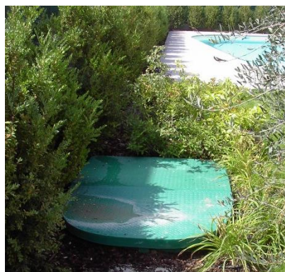
Figura V - Posa locale tecnico ultimata
