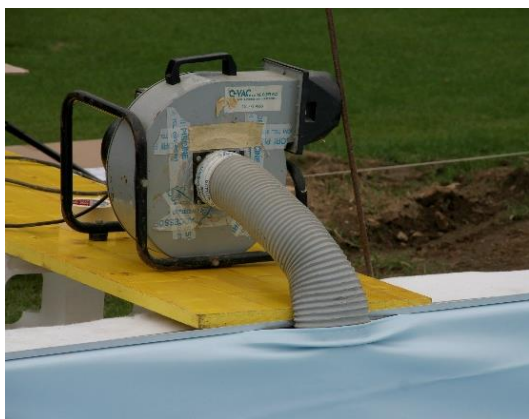
Figura X - Messa in tensione del liner
