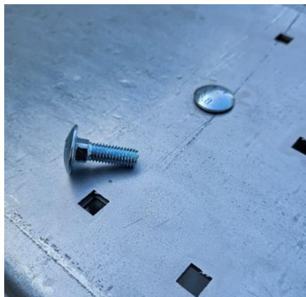
Figura 14 - vite M8 testa tonda e relativi fori
