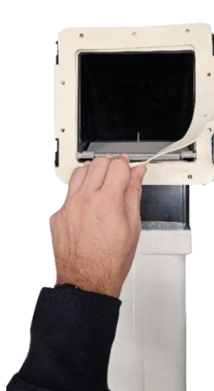
Figura 22 – seconda guarnizione adesiva
