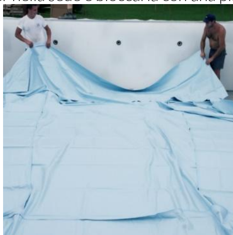
Figura 31 - stesura del liner
