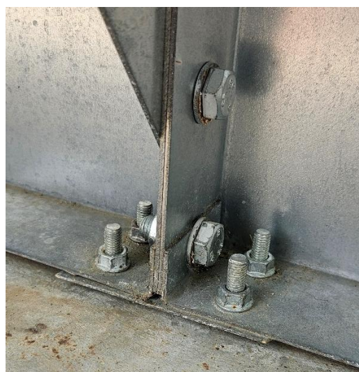
Figura 8 – accoppiamento con pannello e fascetta di base
